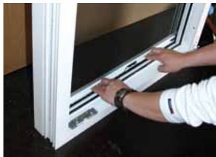
10. Einfaches Einrasten und Lösen der Endschiene mittels Click/Clack-System. Dazu Endschiene mittig nach unten drücken.
