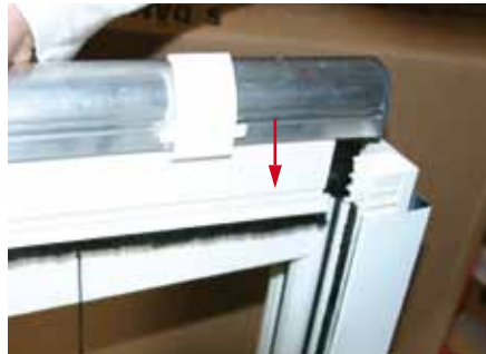
5. Insektenschutzkassette in Aufnahme am Trichter einsetzen, dabei Gewebeendleiste passend in Insektenschutzschiene einführen.
