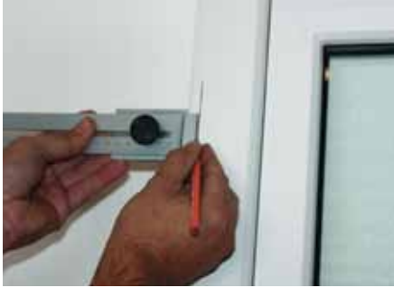
1. Hilfslinie für Montage der Nippelmodule anzeichnen. Wenn die Führung außen bündig mit Rahmen abschließen soll, dann ist die Mitte des Nippelmoduls 12 mm von Kante Rahmen zu setzen.
