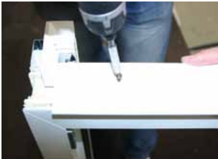
4. Abrollprofil ausgerichtet zwischen Trichtern verschrauben. Das Profil darf nicht nach außen über den Blendrahmen stehen.
