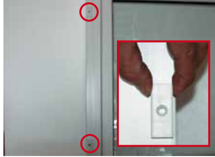
2. Nippelmodule montieren. Bitte beachten: Abgeschliffene Nippelmodule bei Einsatz der Doppelführungsschiene verwenden!
