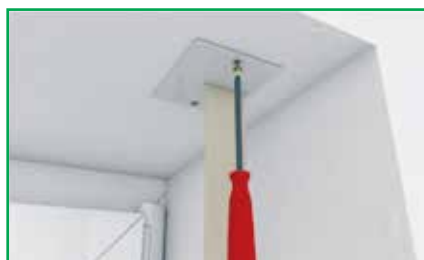
Abschließend die Gurtführung ein- setzen und mit Senkkopf-Schrau- ben fixieren.
