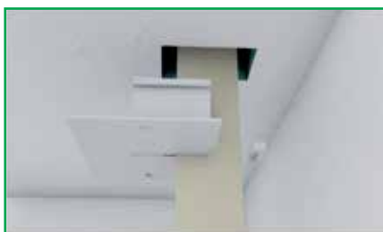
Gurtband einziehen. Montage auch ohne Demontage des Gurtes durch 2-teiliges System möglich.
