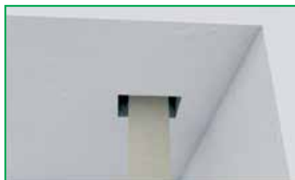
Aussparung für die Montage der Gurtführung anpassen (30x20 mm).
