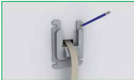
Grundkörper ausrichten und Bohr- löcher einzeichnen.
