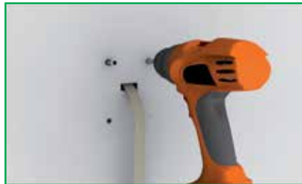
Vorbohren und Dübel setzen.
