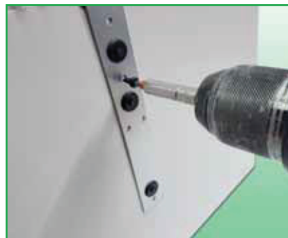
Dübel sind im Bohrloch. Dann Stifte ② einschlagen. Zusätzlich mit Schraube sichern.
