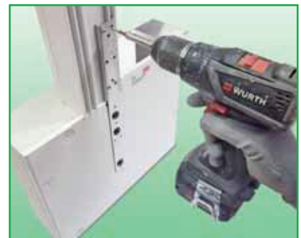
Stiel mit dem äußeren Schenkel in die äußerste Nut des Blendrahmens legen und festschrauben ③.
