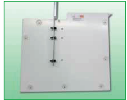
Kunststoffdübel ② in den Befestigungsstiel ① einstecken.
